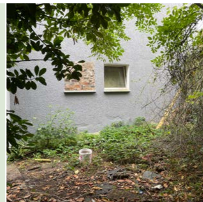
Aufstellplatz der Außeneinheiten vor der Montage.
