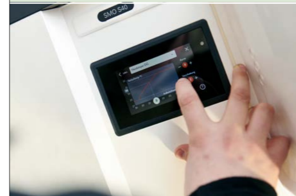
Simon Koop erklärt die NIBE SMO S40: Das effektive Regelgerät reguliert das Raumklima automatisch bei höchstem Komfort.
