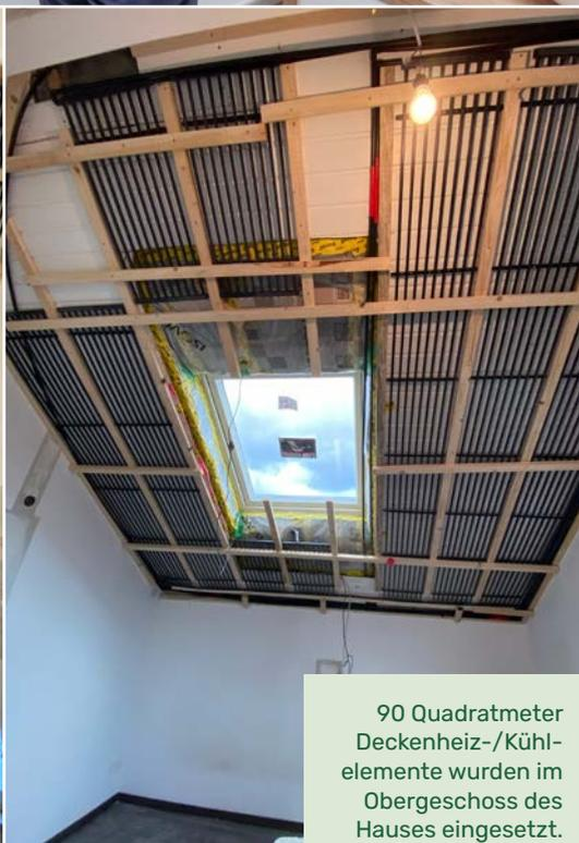
90 Quadratmeter Deckenheiz-/Kühl-elemente wurden im Obergeschoss des Hauses eingesetzt.
