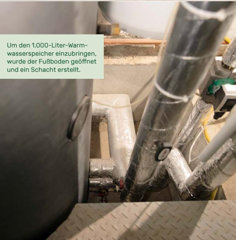
Um den 1.000-Liter-Warmwasserspeicher einzubringen, wurde der Fußboden geöffnet und ein Schacht erstellt.
