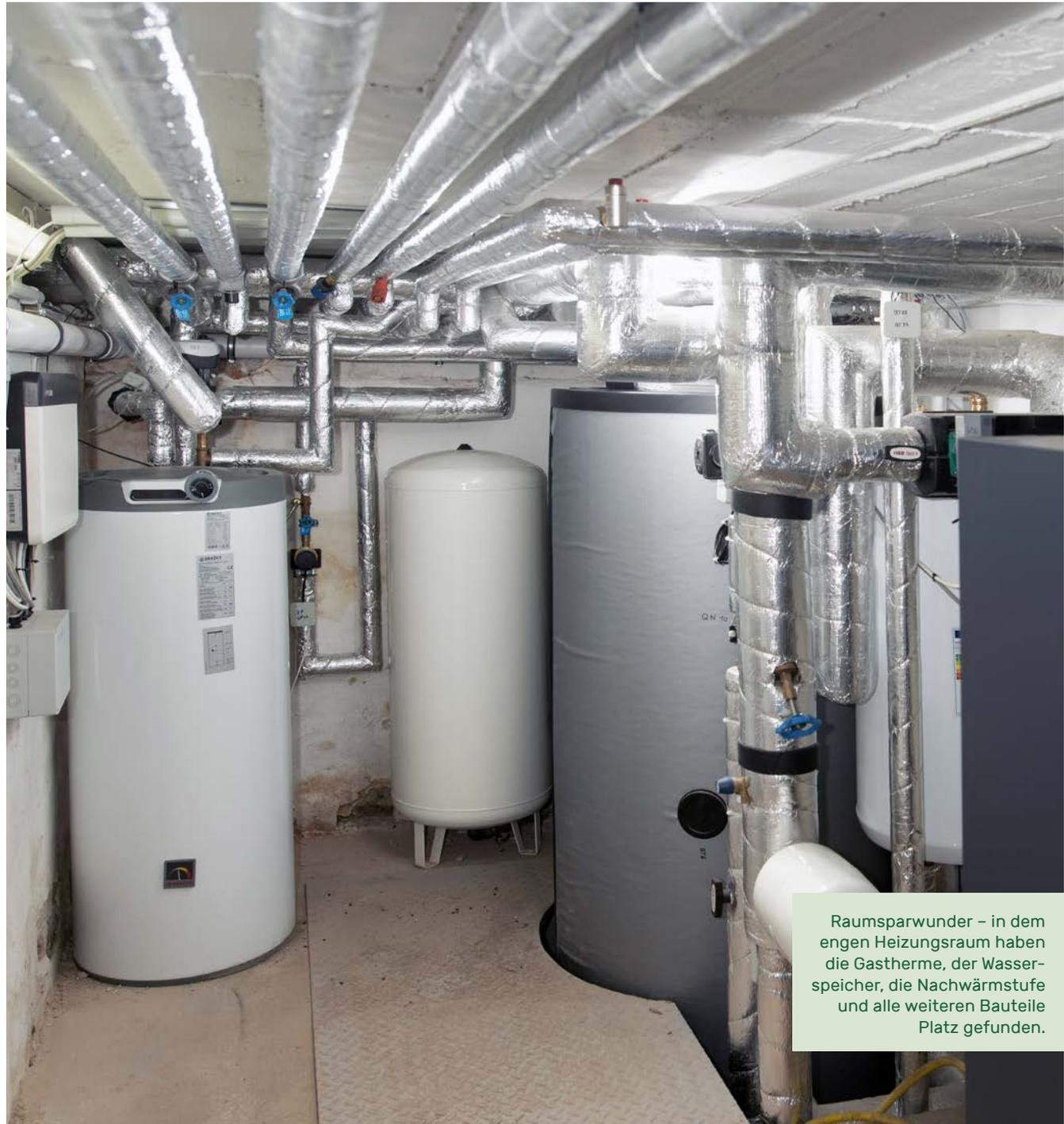
Raumsparspeicher – in dem engen Heizungsraum haben die Gastherme, der Wasserspeicher, die Nachwärmstufe und alle weiteren Bauteile Platz gefunden.
