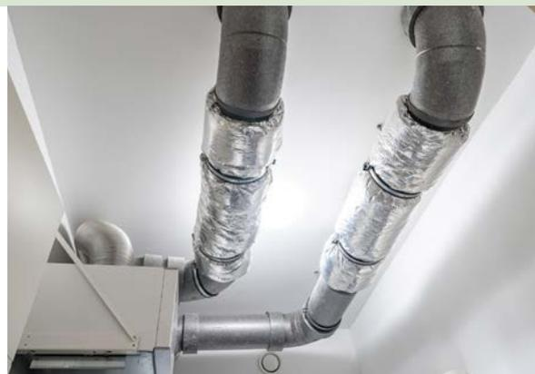
Die mit der Abluft-Wärmepumpe realisierte Wohnungslüftung sorgt für eine optimale Nutzung der verbrauchten Raumluft als Wärmequelle für Heizung und Warmwasser. Das Zuluftmodul bringt sauerstoffreiche Frischluft gefiltert und vorerwärmt in die Räume ein und erzeugt damit ein gesundes Raumklima.
