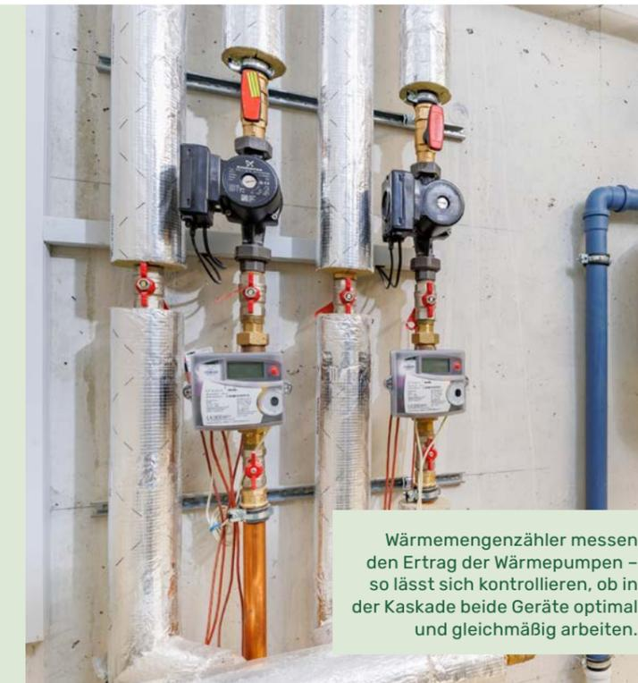
Wärmemengenzähler messen den Ertrag der Wärmepumpen – so lässt sich kontrollieren, ob in der Kaskade beide Geräte optimal und gleichmäßig arbeiten.
