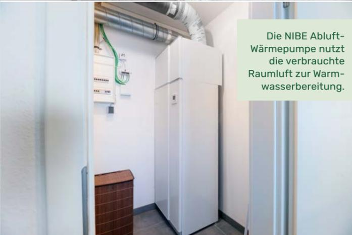
Die NIBE Abluft-Wärmepumpe nutzt die verbrauchte Raumluft zur Warmwasserbereitung.
