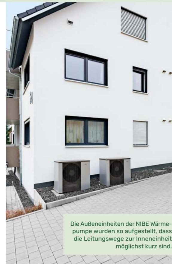
Die Außeneinheiten der NIBE Wärmepumpe wurden so aufgestellt, dass die Leitungswege zur Inneneinheit möglichst kurz sind.
