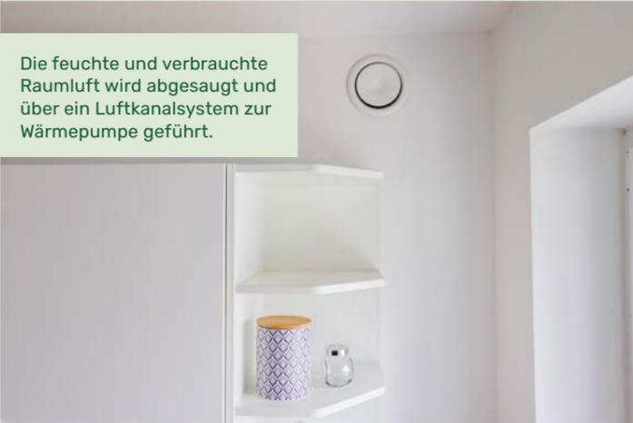
Die feuchte und verbrauchte Raumluft wird abgesaugt und über ein Luftkanalsystem zur Wärmepumpe geführt.
