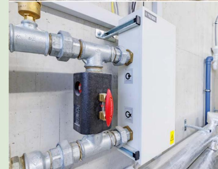
Die Heizkassette mit Bypass-Ventil dient für die Versorgung im Notfallbetrieb.
