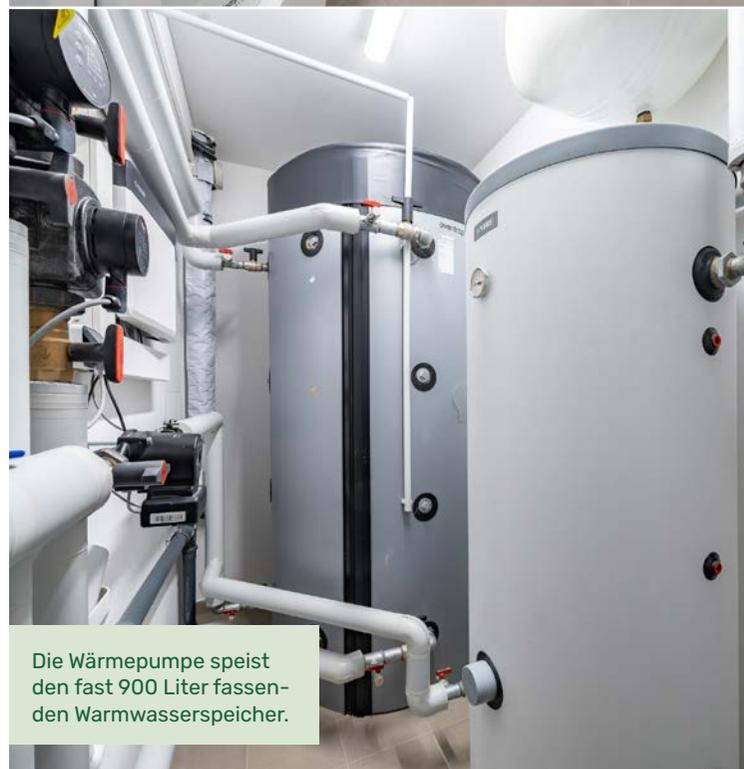
Die Wärmepumpe speist den fast 900 Liter fassenden Warmwasserspeicher.
