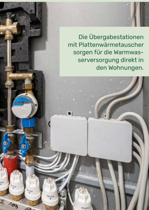
Die Übergabestationen mit Plattenwärmetauscher sorgen für die Warmwasserversorgung direkt in den Wohnungen.
