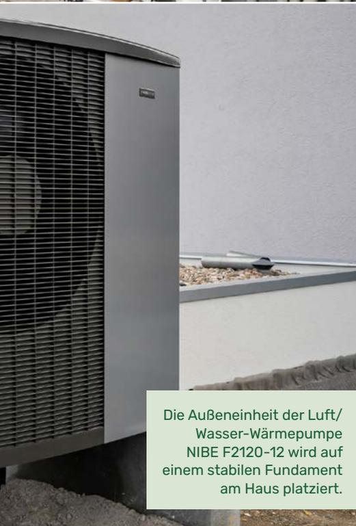
Die Außeneinheit der Luft/Wasser-Wärmepumpe NIBE F2120-12 wird auf einem stabilen Fundament am Haus platziert.
