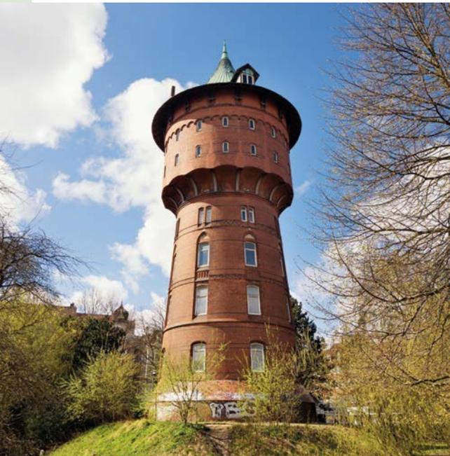
Der 48 Meter hohe Wasserturm von 1897 ist ein Wahrzeichen der Stadt Cuxhaven. Der Gefälledruck reichte etwa ab 1970 für die höheren Häuser nicht aus, sodass sie mit Druckerhöhungsanlagen ausgestattet werden mussten. 2004 wurde der Wasserturm außer Betrieb genommen.
