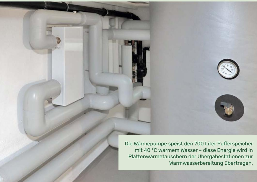
Die Wärmepumpe speist den 700 Liter Pufferspeicher mit 40 °C warmem Wasser – diese Energie wird in Plattenwärmetauschern der Übergabestationen zur Warmwasserbereitung übertragen.
