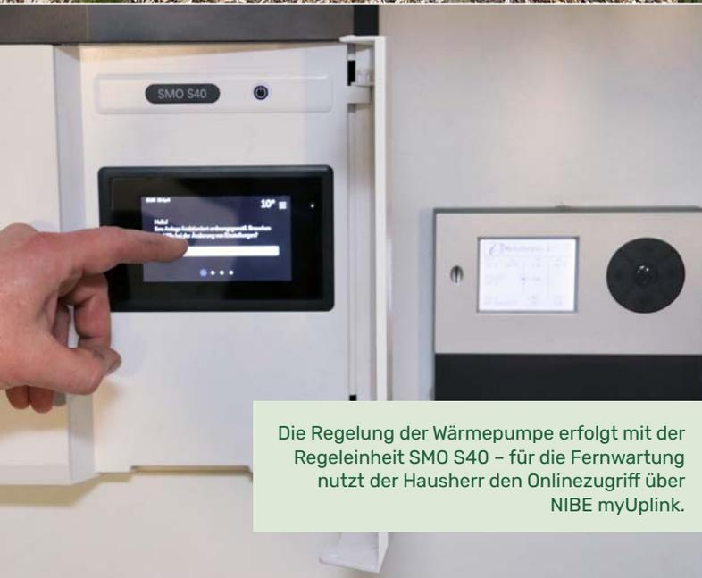
Die Regelung der Wärmepumpe erfolgt mit der Regeleinheit SMO S40 – für die Fernwartung nutzt der Hausherr den Onlinezugriff über NIBE myUplink.
