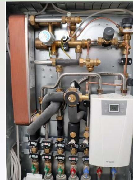
Das Herzstück der Heizung und Warmwasserverteilung: die Clage-Übergabestation mit Plattenwärmetauscher, Durchlauferhitzer und Heizkreisbindung für die Fußbodenheizung.
