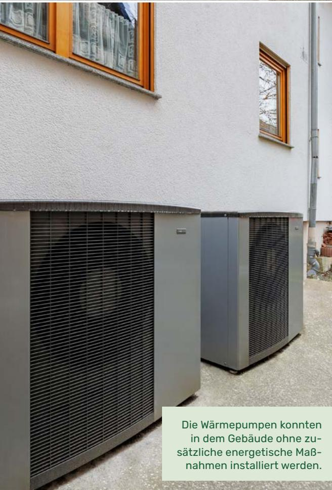
Die Wärmepumpen konnten in dem Gebäude ohne zusätzliche energetische Maßnahmen installiert werden.
