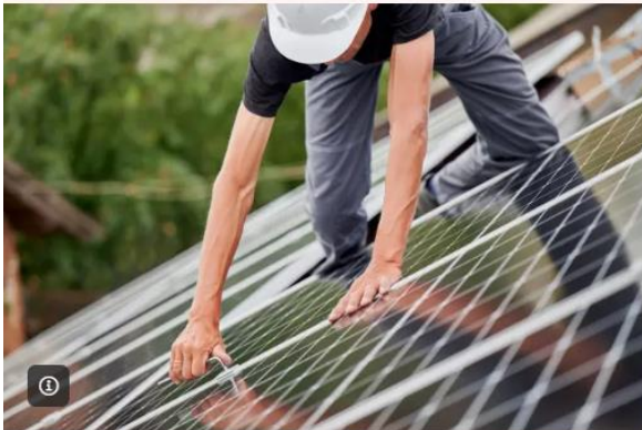
Instalace střešní elektrárny.
