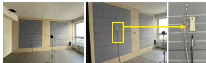
Obr. 6 Realizace velkoplošného stěnového systému v místnosti 203 s lokalizací snímače tepelného toku. (Autor: Martin Šimko)
