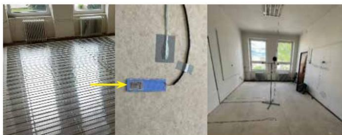
Obr. 4 Realizace velkoplošného sálavého podlahového systému v místnosti 202.1 s lokalizací snímače tepelného toku. (Autor: Martin Šimko)
