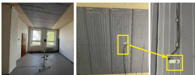
Obr. 5 Realizace velkoplošného sálavého podlahového systému v místnosti 202.2 s lokalizací snímače tepelného toku. (Autor: Martin Šimko)
