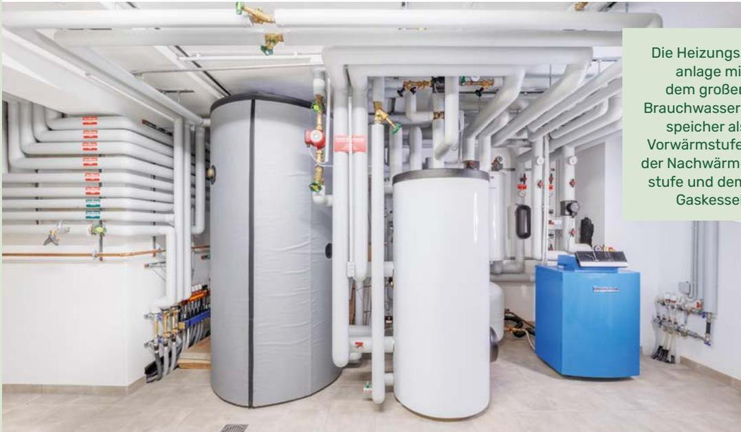
Die Heizungsanlage mit dem großen Brauchwasserspeicher als Vorwärmstufe, der Nachwärmstufe und dem Gaskessel.
