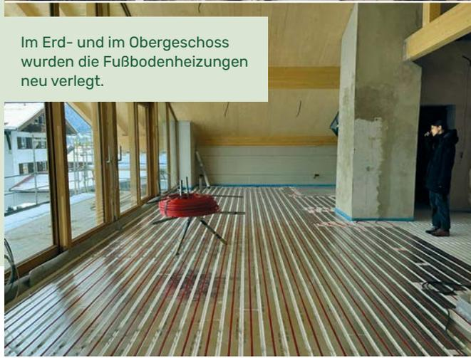
Im Erd- und im Obergeschoss wurden die Fußbodenheizungen neu verlegt.
