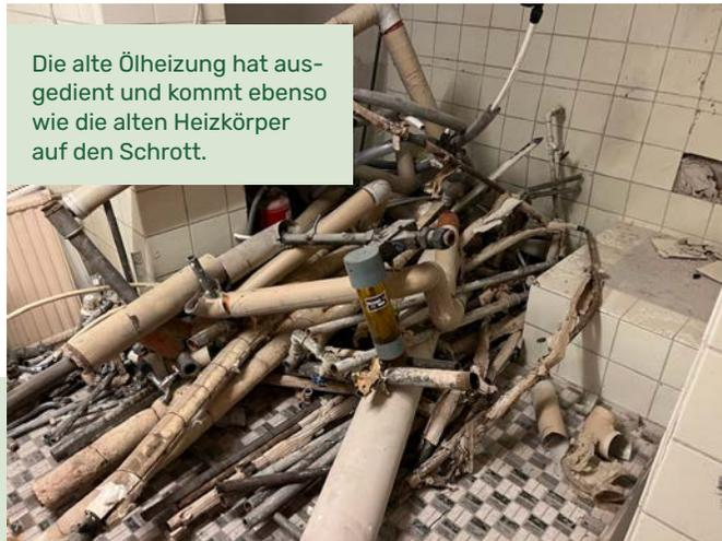
Die alte Ölheizung hat ausgedient und kommt ebenso wie die alten Heizkörper auf den Schrott.
